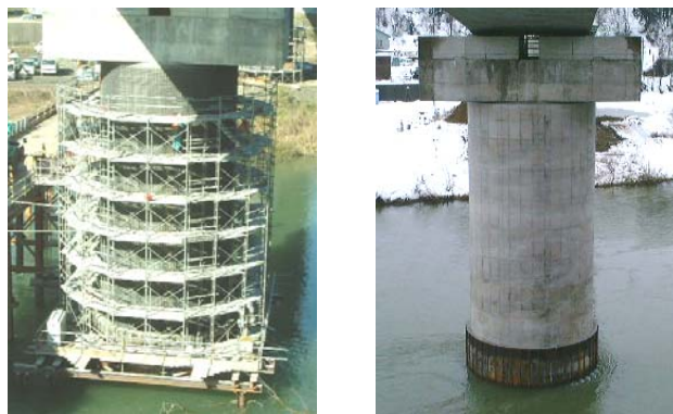
図6 復旧状況（左：鉄筋組立て状況、右：復旧後）
