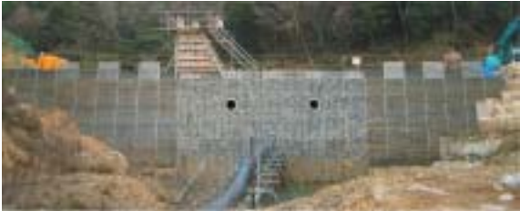
写真－1 完成直前の固化処理ダム全景
