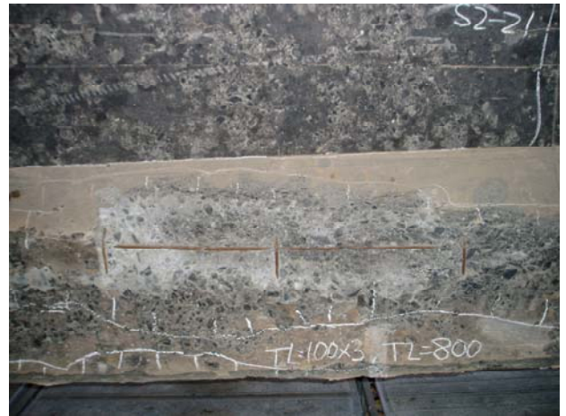
写真-1 下フランジ変色・剥離状況
