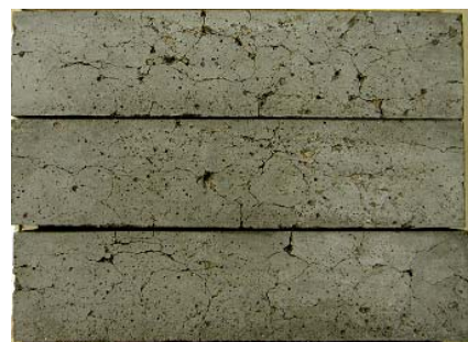
写真1 含水率30%の軽量粗骨材を用いたコンクリートの凍結融解36サイクル終了時の状況
