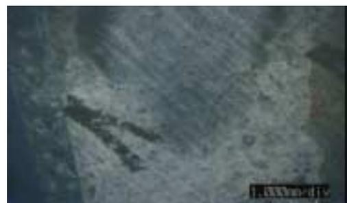
写真-8 ひび割れへの注入材充填状況
