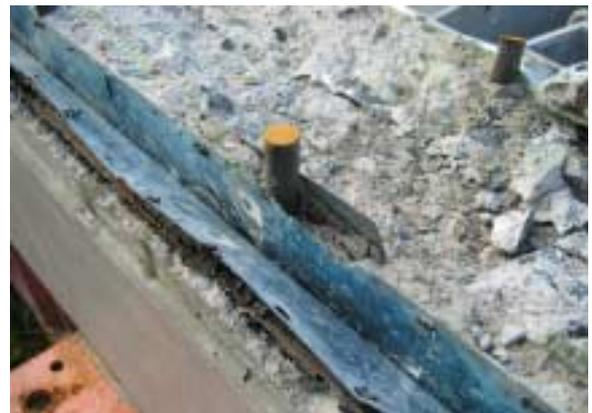
写真-7 誘発目地裏面への注入材充填状況
