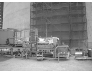
写真-5 グラウト注入プラント
