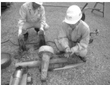
写真-4 グラウト充填状況(ガイド部)
