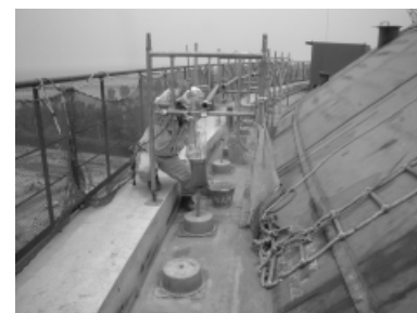
写真-6 グラウト充填状況
