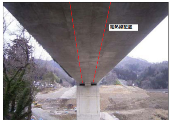
写真-4 下床版電熱線配置位置
