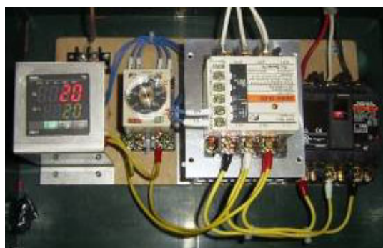
写真-1 養生温度制御装置設置状況
