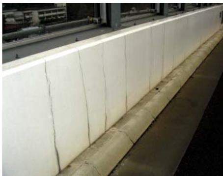
写真-1 既設高欄コンクリートひびわれ
