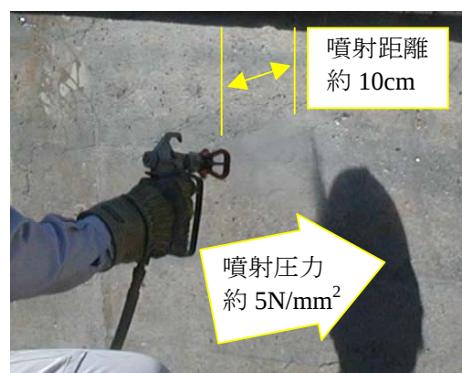
写真－1 標準施工状況
