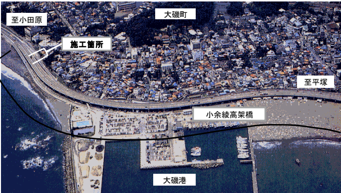
写真－1 小余綾高架橋の全景
