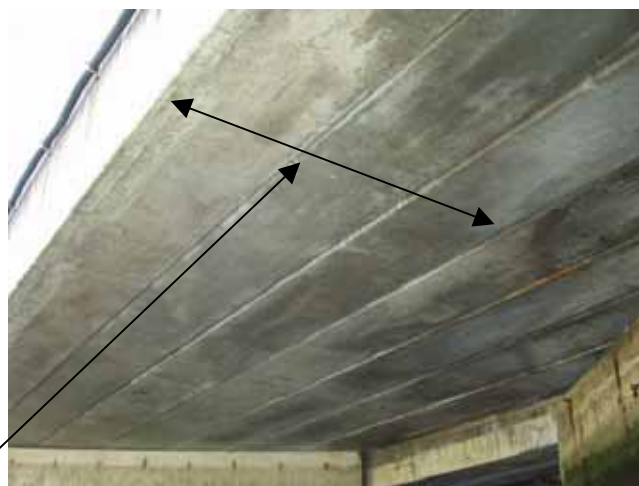
写真－1 PC 桁の状況写真
