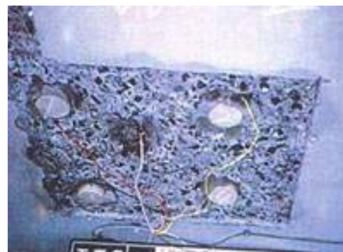
写真-1 犠牲陽極材の設置状況
