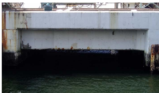
写真 1 電気防食工法施工前の栈橋外観
