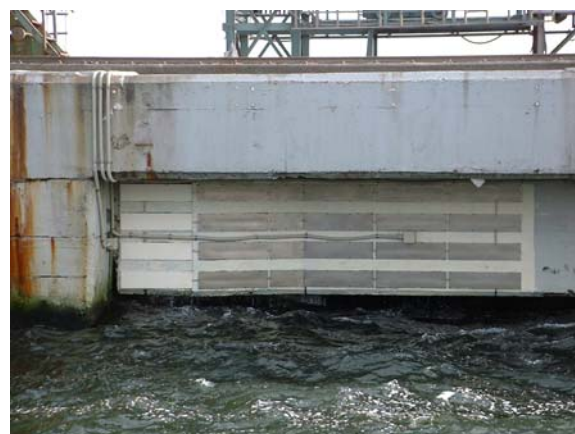
写真2 電気防食工法施工後の栈橋外観
