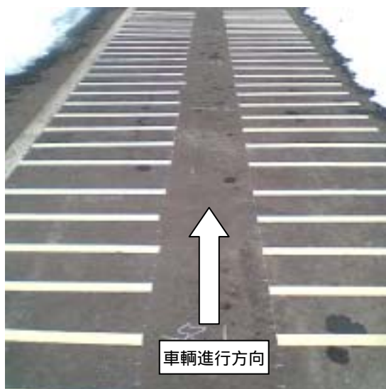
写真-1 本工法の舗装路面（テープ部を白で示した）
