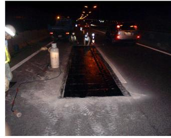
図 - 3 アスファルトシート設置
