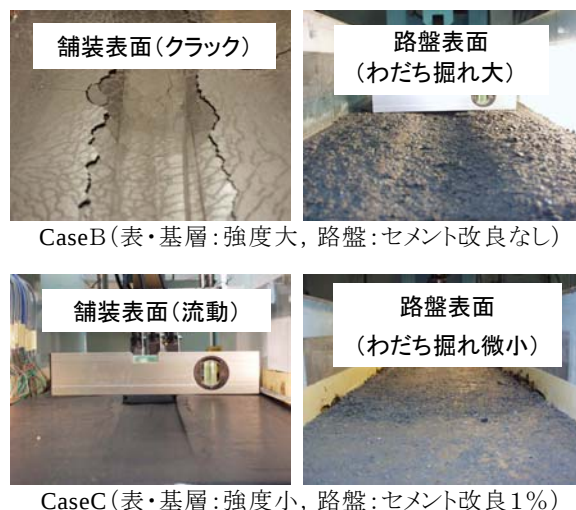
図9 舗装の破壊形状
