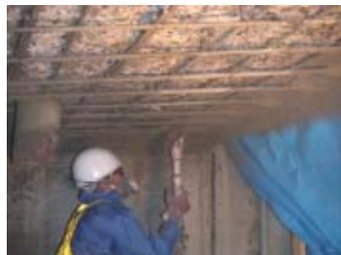
写真-1 橋梁床版吹付け状況
