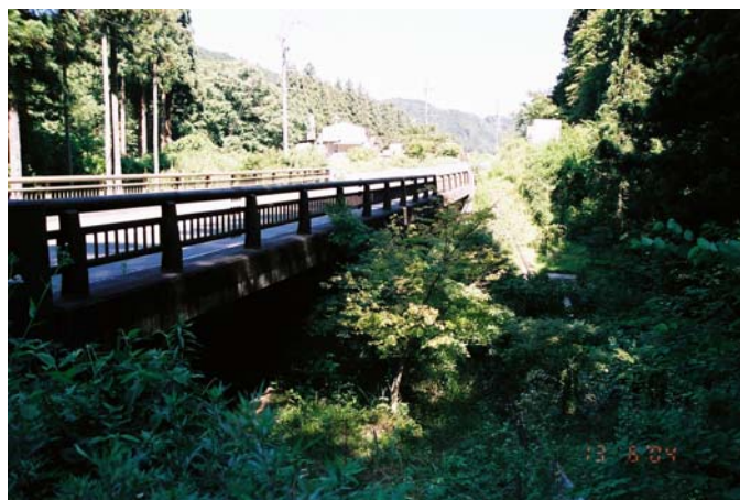
図 1 日当たり及び風通しの悪い橋梁例（T 橋）
