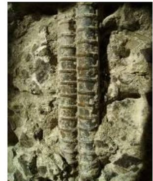
写真-2 地山側鉄筋 (B, 露出部)
