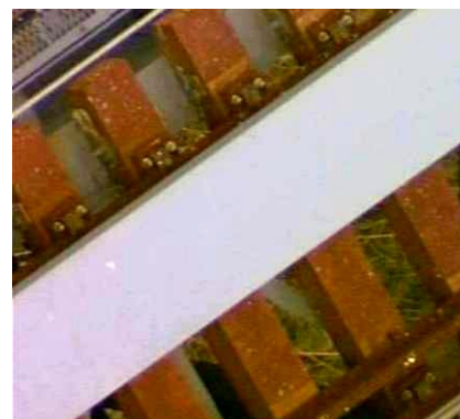
図-7 塗装塗替後の上弦材 (図-5と同じ箇所)
