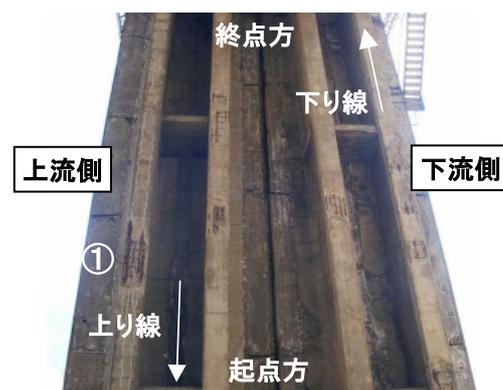
図6 桁下面はつり後の状況
