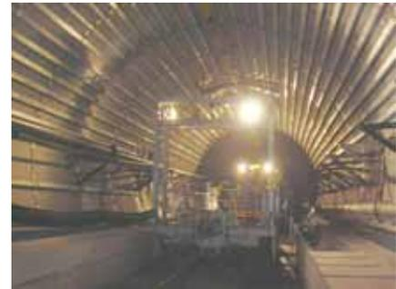
写真2 仮設梁取り付け状況
