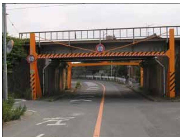
図 1.1 従来の橋けた防護工
