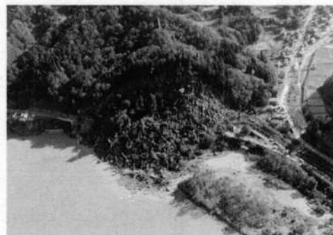
図1 崩壊箇所斜め写真
