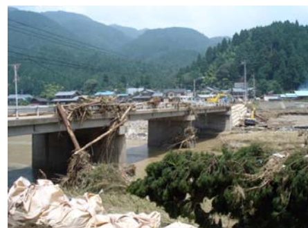
写真-5 高田大橋(道路橋)の状況
