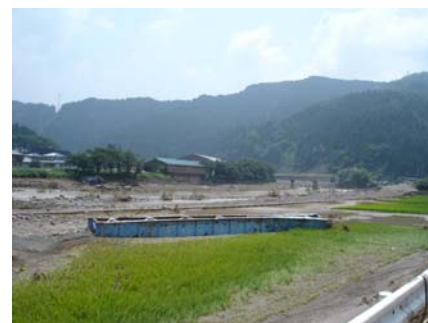
写真-2 第1鉄橋桁の流出状況
