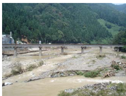
写真-3 第2鉄橋の状況
