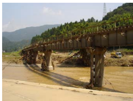
写真-9 第6鉄橋の状況
