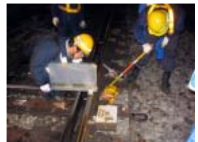
写真3 直基本レール 通り整正
