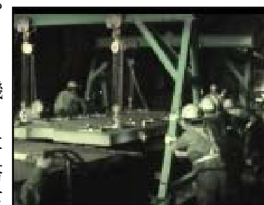
写真2 大形クレーンによる吊上げ
