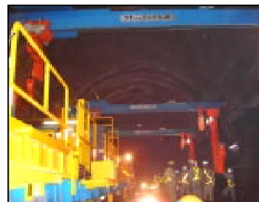
写真4 スラブ交換機（作業時）
