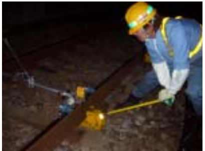
(写真) レーザー光点を見ながらジャッキアップの様子
