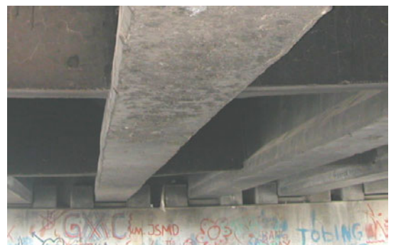
写真8 変位制限構造が正常に機能した橋梁
