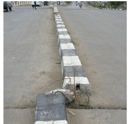
写真7 地震により上部工が移動した橋梁
