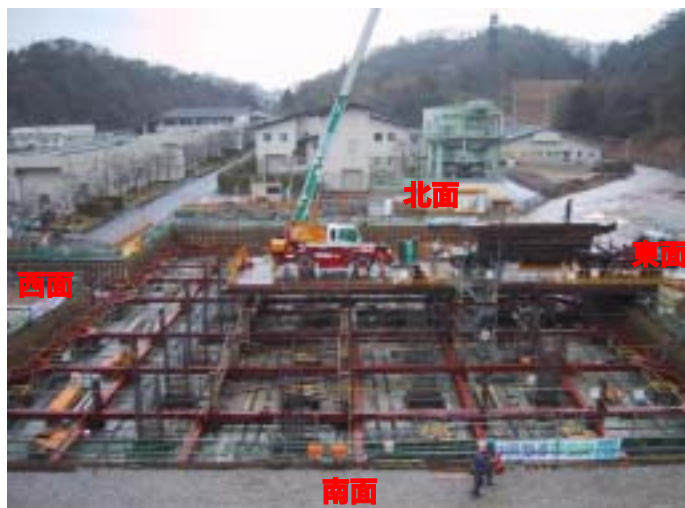
写真1 現場全景《南から北方向を望む》
