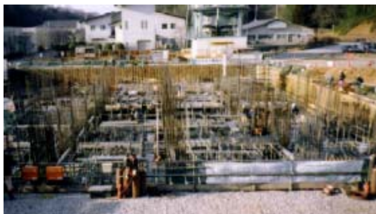
写真2 現場全景《南から北方向を望む》
