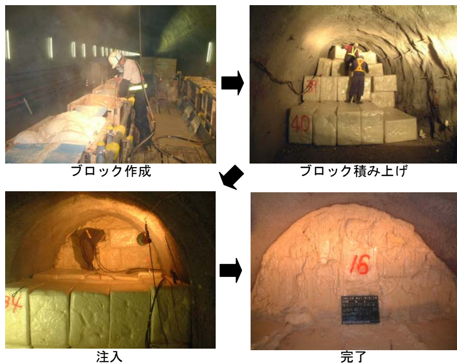
図 4 施工フロー写真
