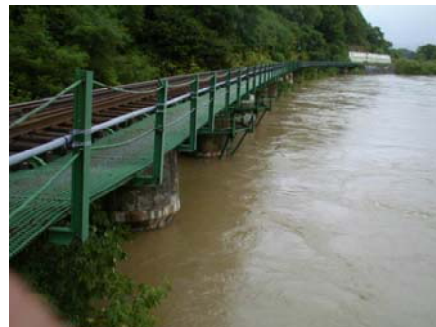
図1 天塩川増水時の問平陸橋
