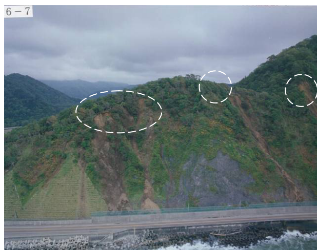
写真-1 ”十勝沖”後の崩壊歴
