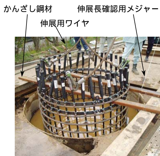
写真-3 建込み実験状況
