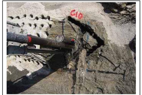
図-4 コンクリートブロックでの自由面形成状況
