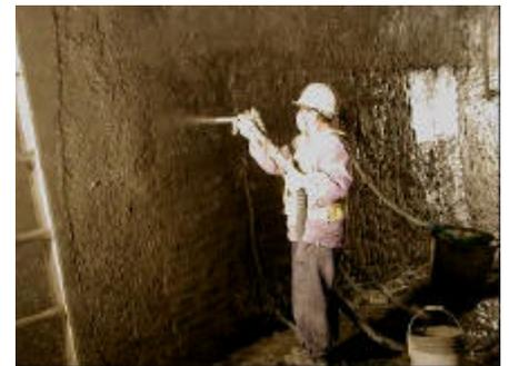
写真-2 吹付けECC施工状況
