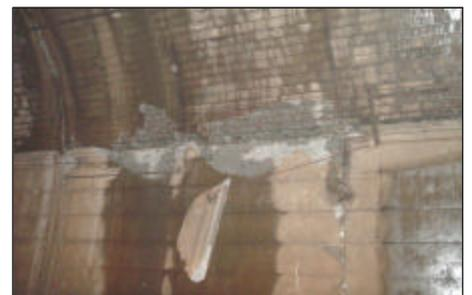
写真 - 1 側壁コンクリートの剥落
