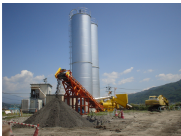
写真-1.浚渫土の改良状況
