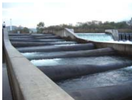
写真1 ハーフコーン型魚道(多摩川・日野用水堰)
