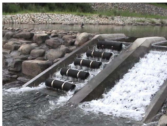
写真1 透過性パイプを有するエコステップ魚道
