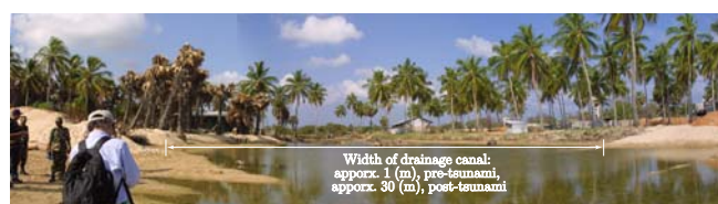
写真-1 津波の遡下時に大きく断面幅が拡張された水路
