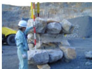
写真－2 吊り下げ状況
