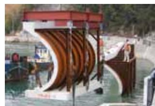
写真 7 フレア護岸据付状況
