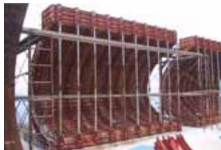
写真 3 型枠組立状況
