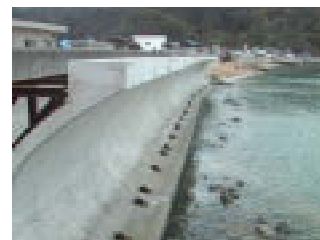
図-1 フレア護岸施工例
