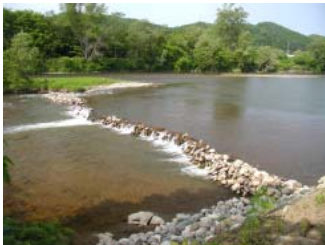
写真-1 連結礫工による構造物の例
