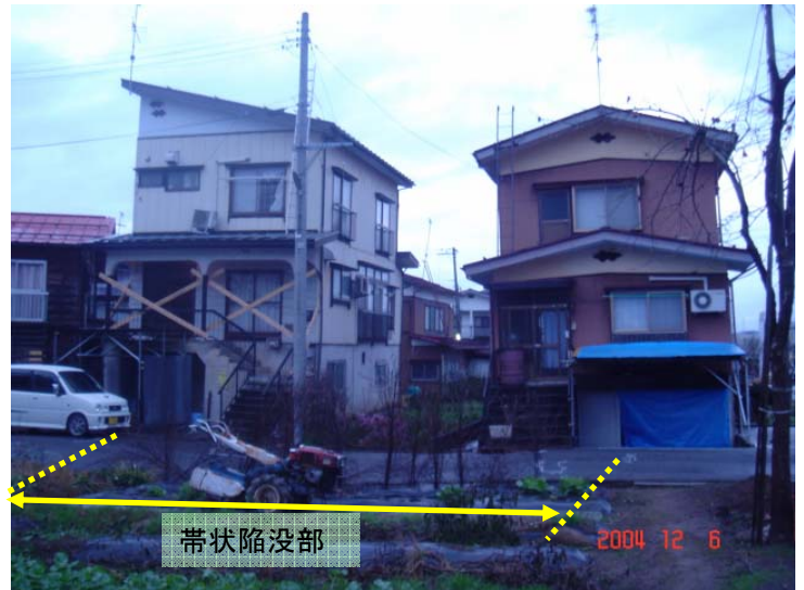
写真-1 帯状陥没部を跨ぎ向かい合うように傾斜した2棟の家屋（十日町市美雪町2丁目）
