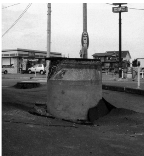
写真-1 マンホールの浮き上がり 写真-2 管渠埋め戻し部の陥没
