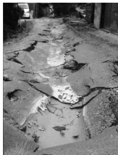
写真-1 マンホールの浮き上がり 写真-2 管渠埋め戻し部の陥没
