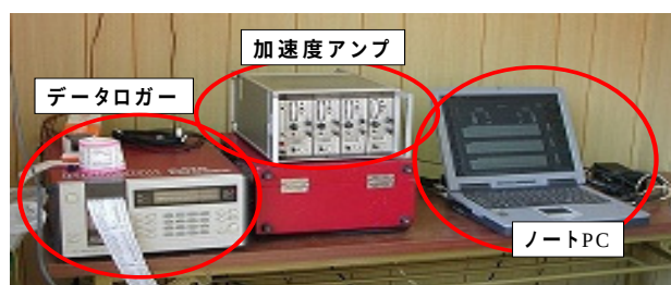
図-4 サーバの設置状況
