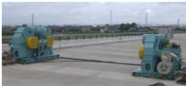
図-2 起振機設置状況
