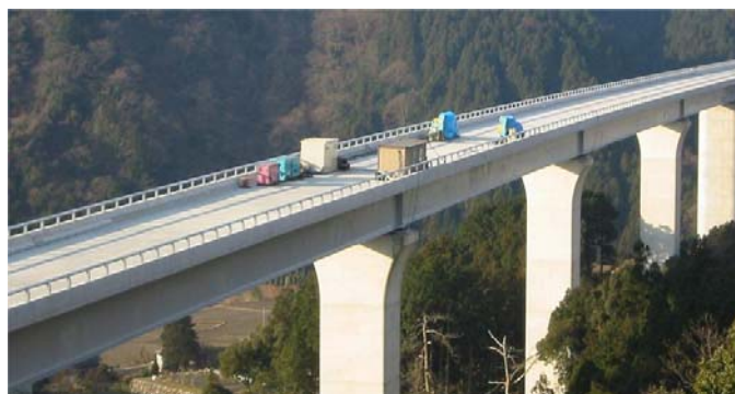
写真-1 起振機の設置状況
