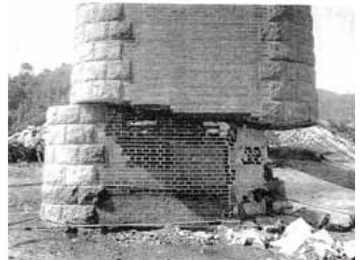
写真-1 関東大地震による橋梁被害
